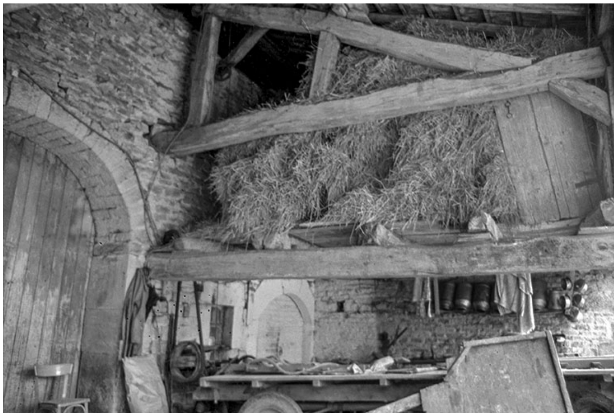
Détail de la charpente en 1974.
