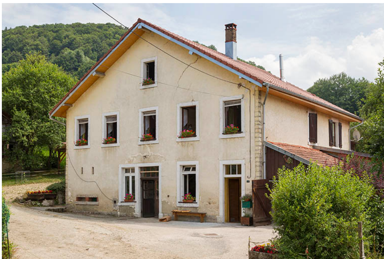
Façades antérieure et latérale droite.
