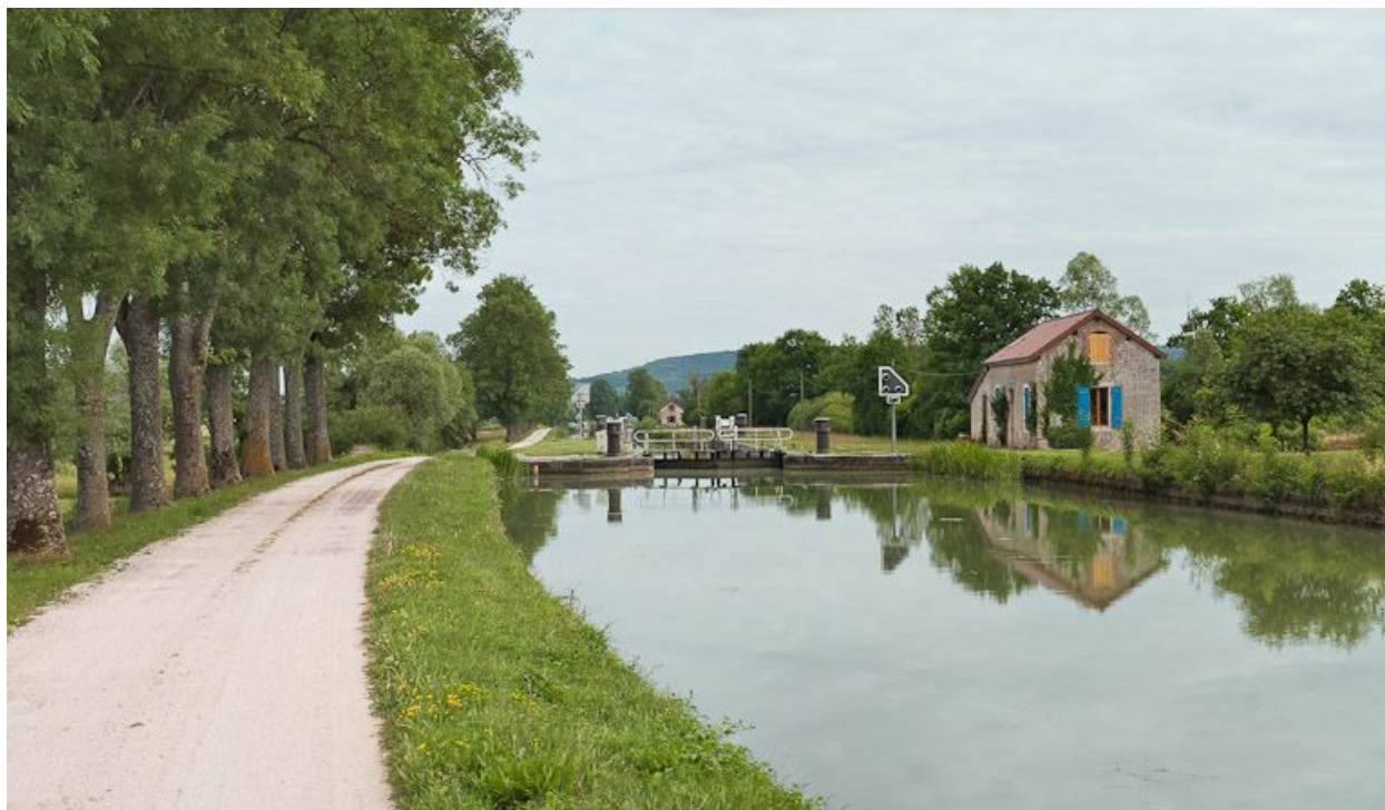
Vue d'ensemble du site d'écluse.
