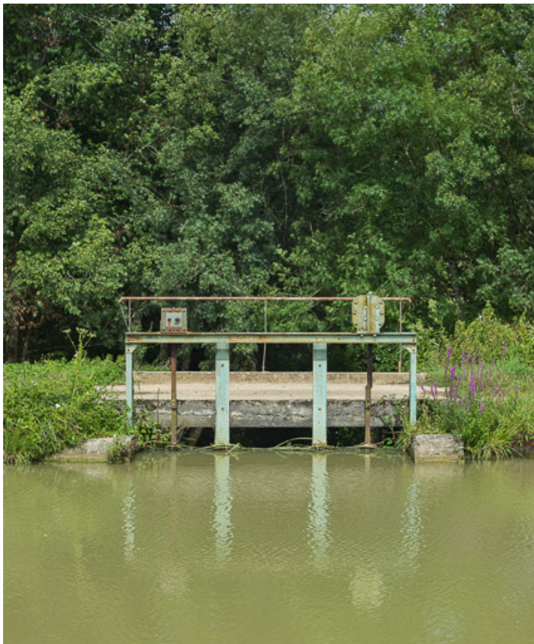
Vue du déversoir.
