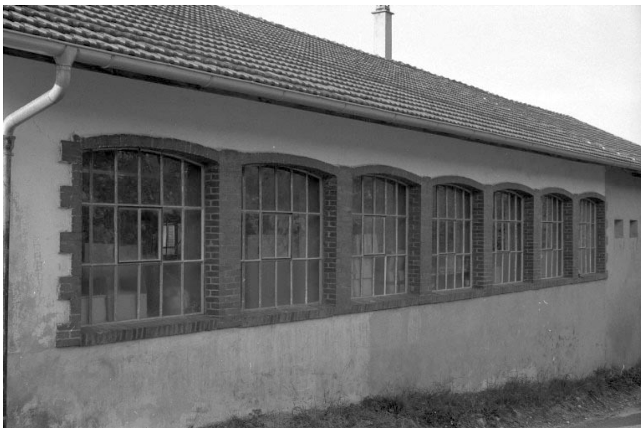
Fenêtres de la façade latérale droite.
