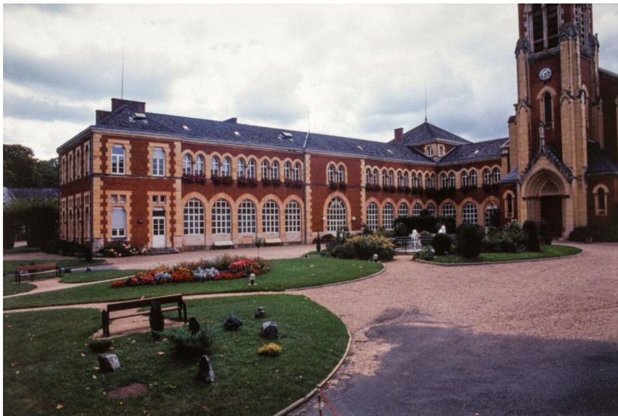
Aile gauche, façade antérieure.
