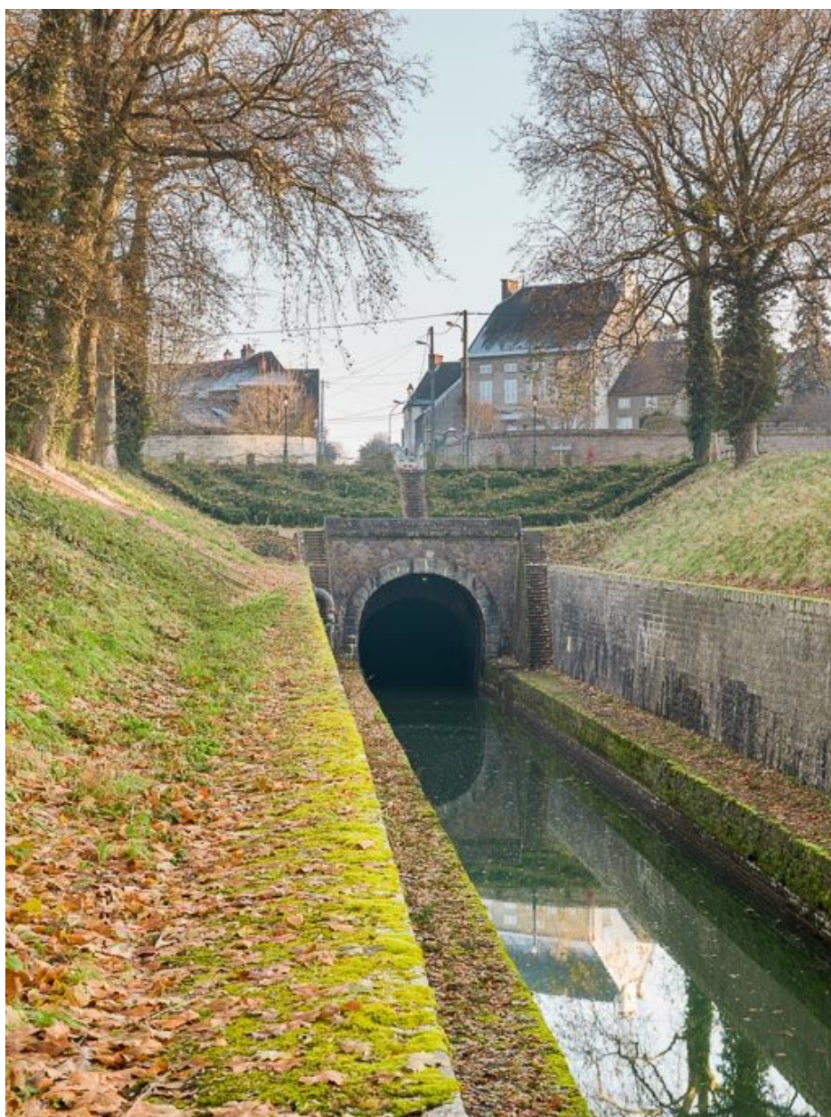
Sortie du tunnel côté Pouilly.
