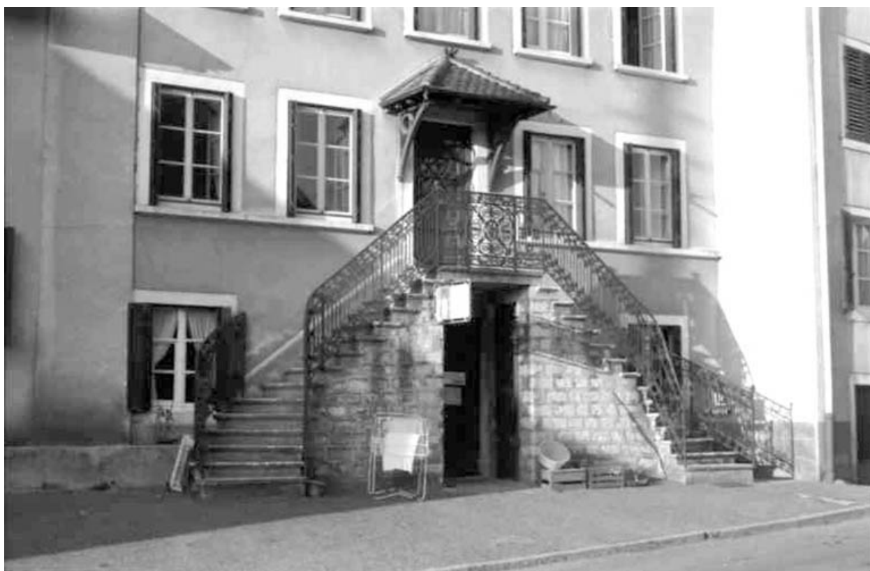
Détail de l'escalier.
