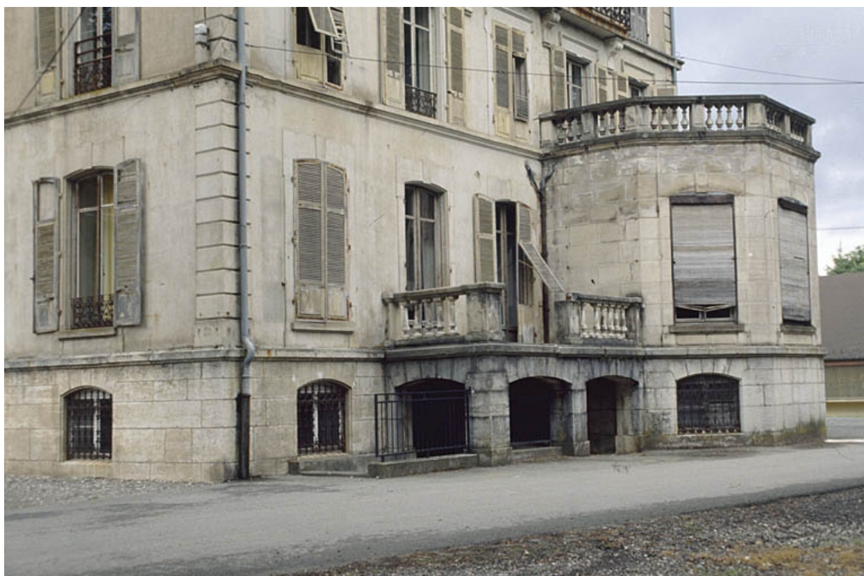
Détail de la façade est.
