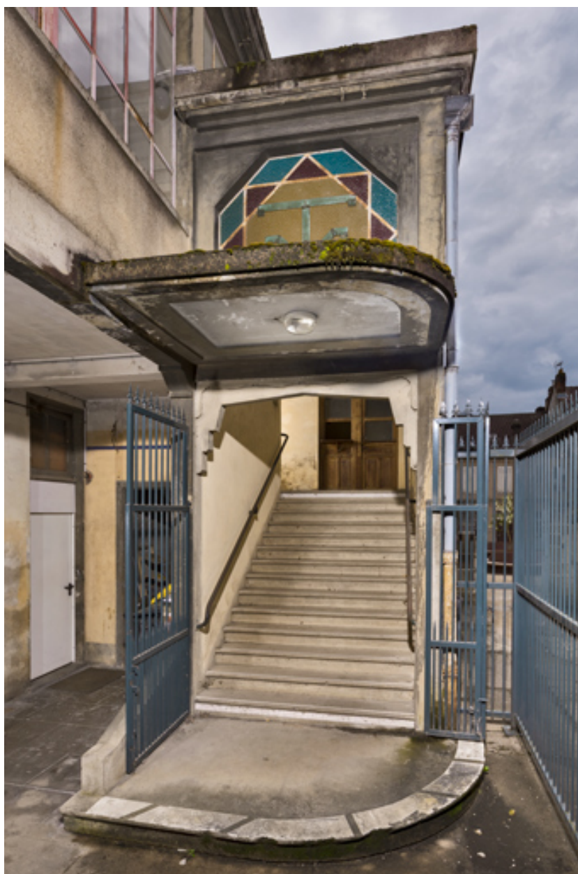
Cage de l'escalier principal.
