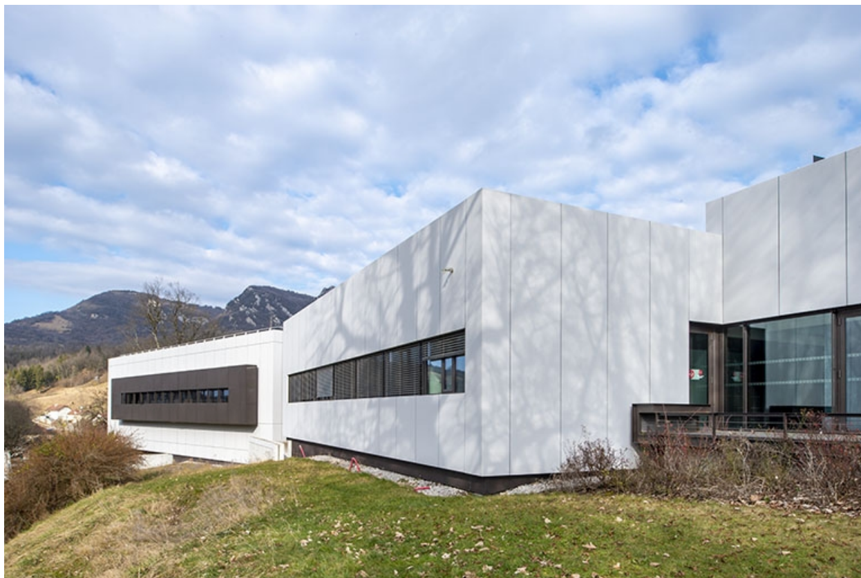
Vue depuis le sud-ouest.
