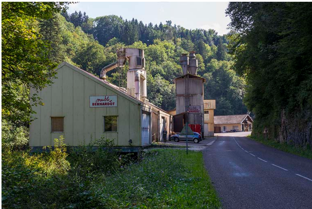
Vue d'ensemble du site, depuis le nord.
