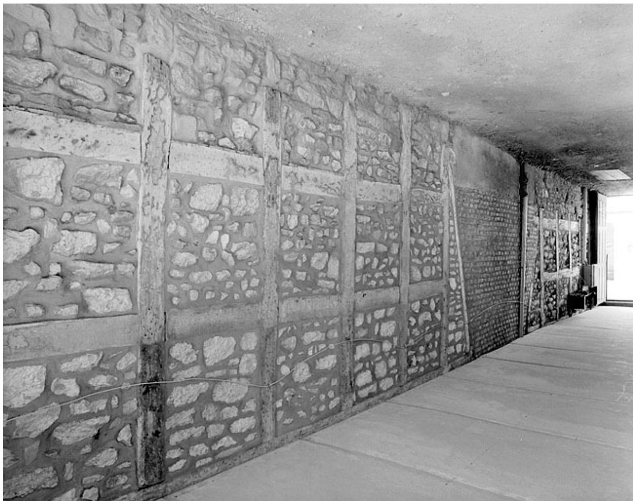
Cloison délimitant l'allée cochère dans le corps de bâtiment oriental.
