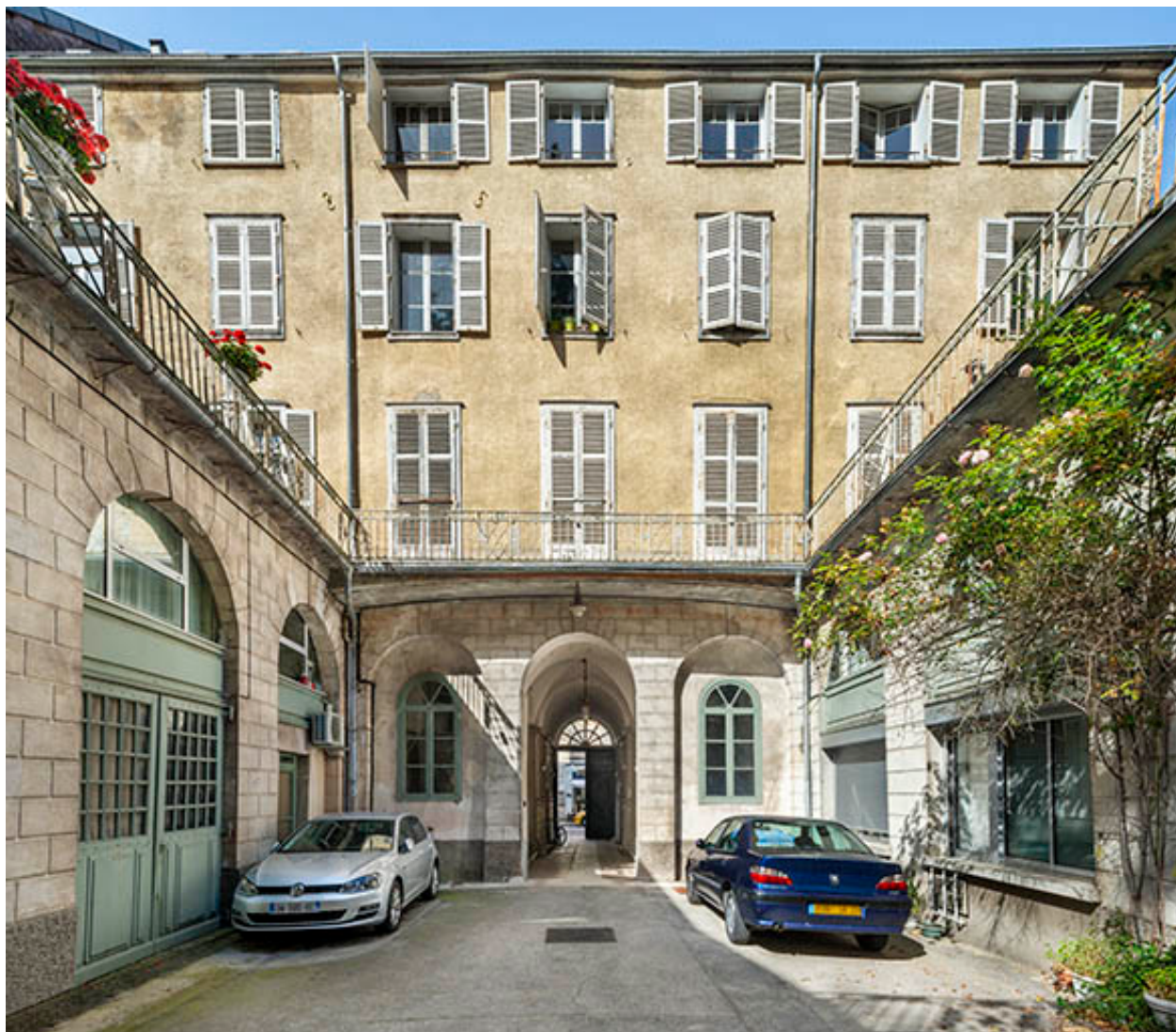
Façade postérieure vue depuis la cour.
