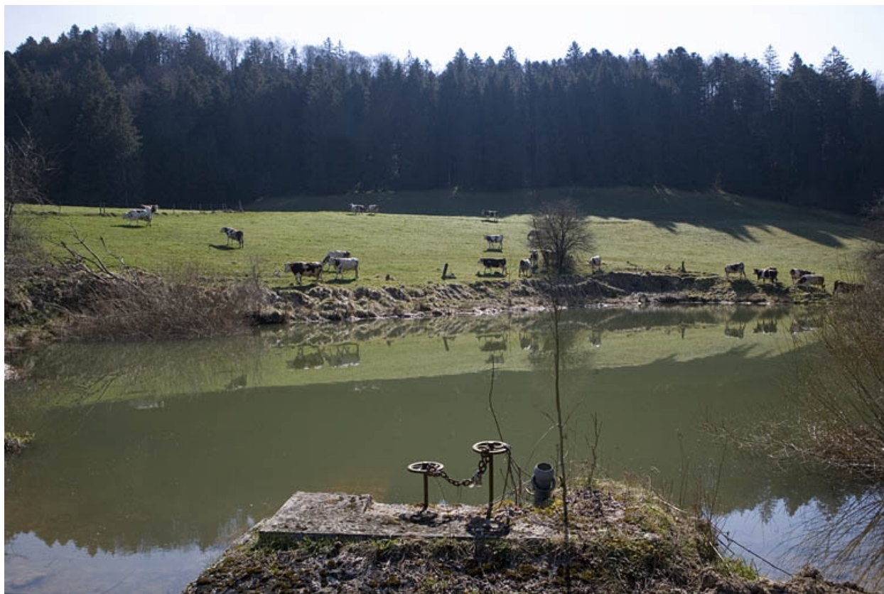
Réservoir : vue d'ensemble, depuis l'ouest.
