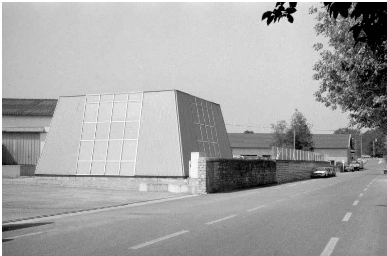
Bâtiment de la société SERIG.
