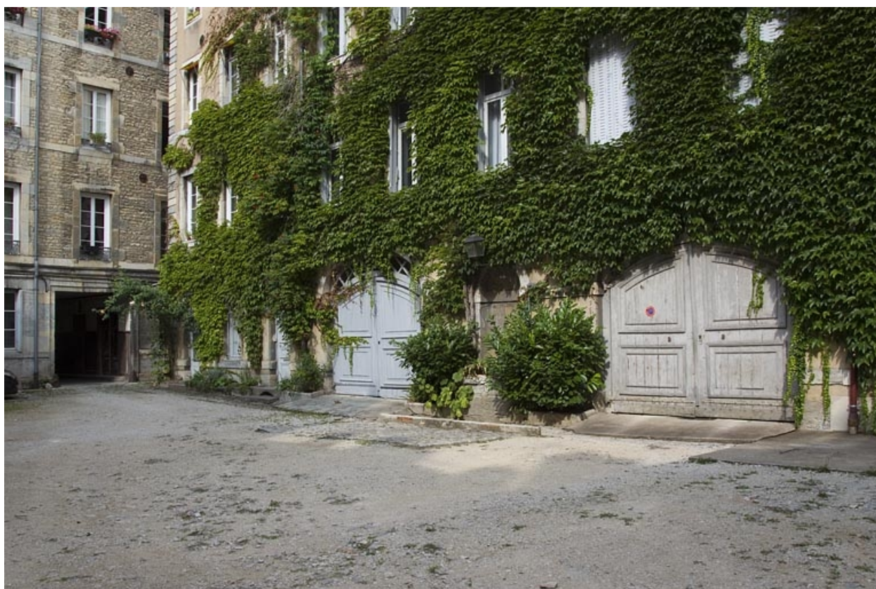
Premier logis secondaire, rez-de-chaussée : détail des remises.
