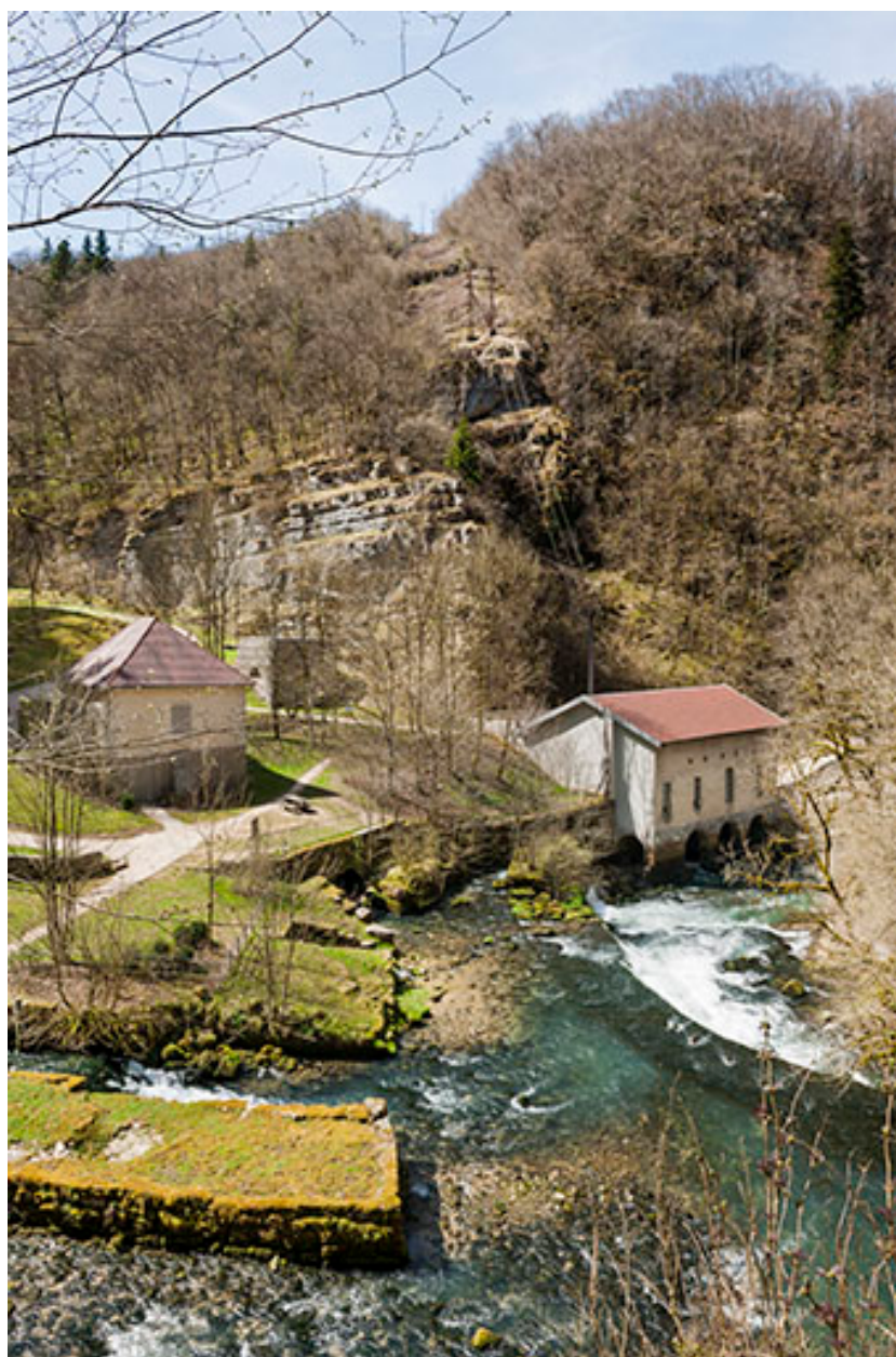
Vue d'ensemble plongeante depuis le sud.
