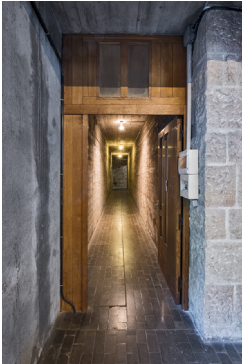
Couloir situé derrière le mur du chœur de l'église et reliant la sacristie à la chapelle. Vue depuis la chapelle.
