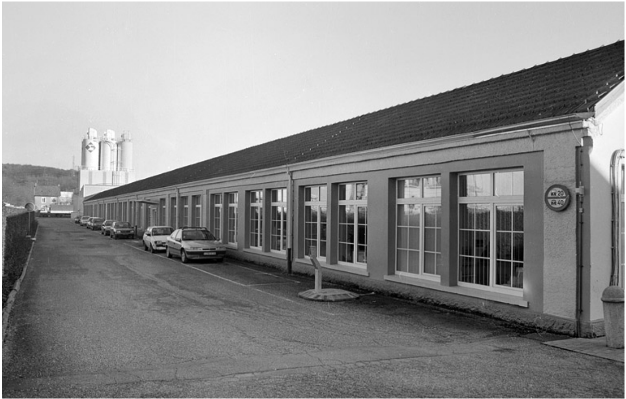
Façade nord de l'atelier de fabrication.
