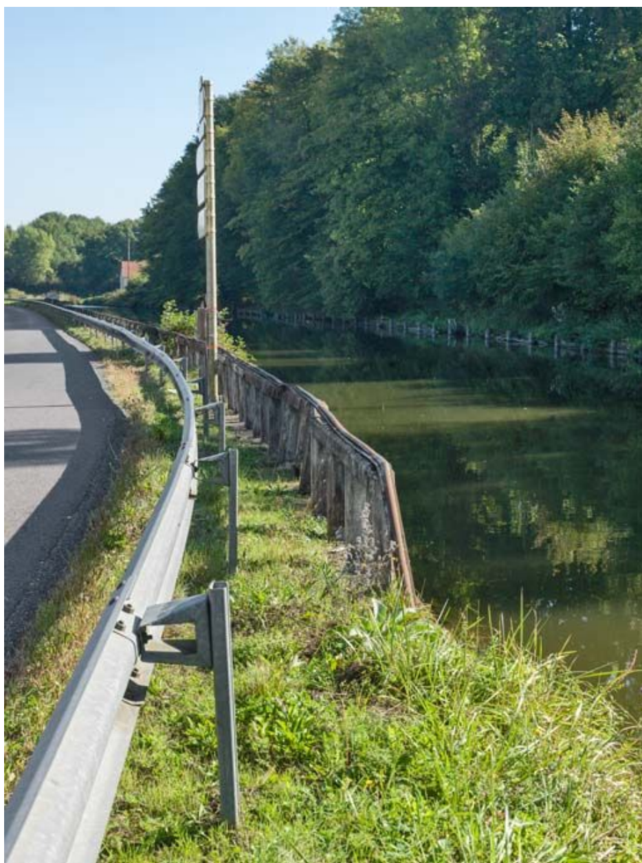
Vue du garde-corps métallique ancien.
