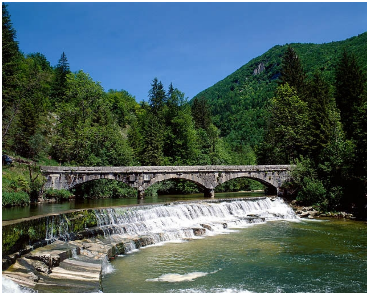
Vue générale depuis l'aval.
