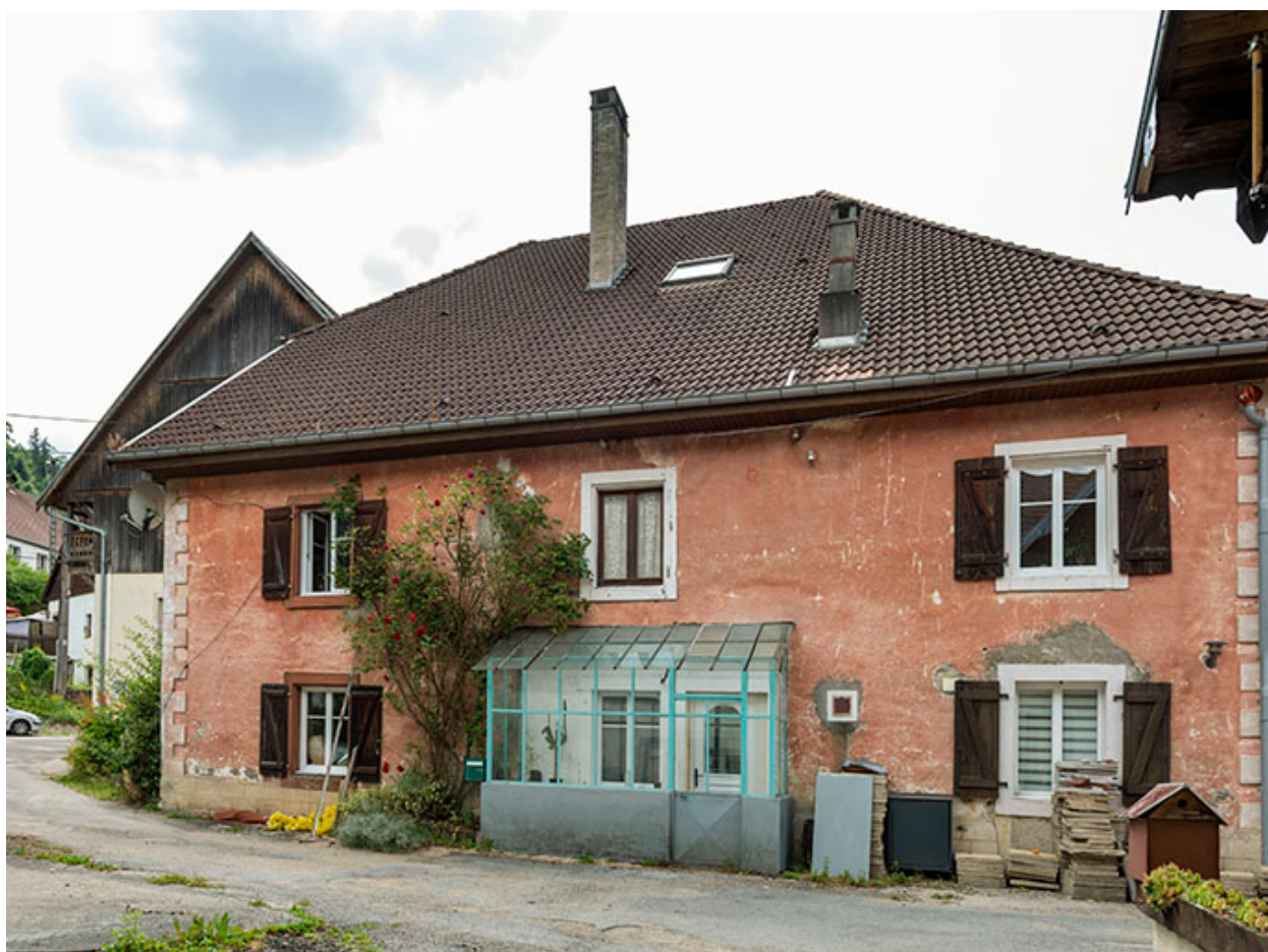
Maison : façade est (côté cour).
