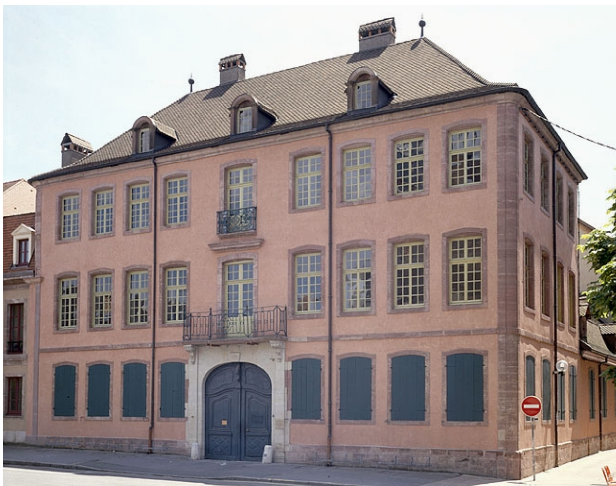
Façade principale sur la place Saint-Martin.
