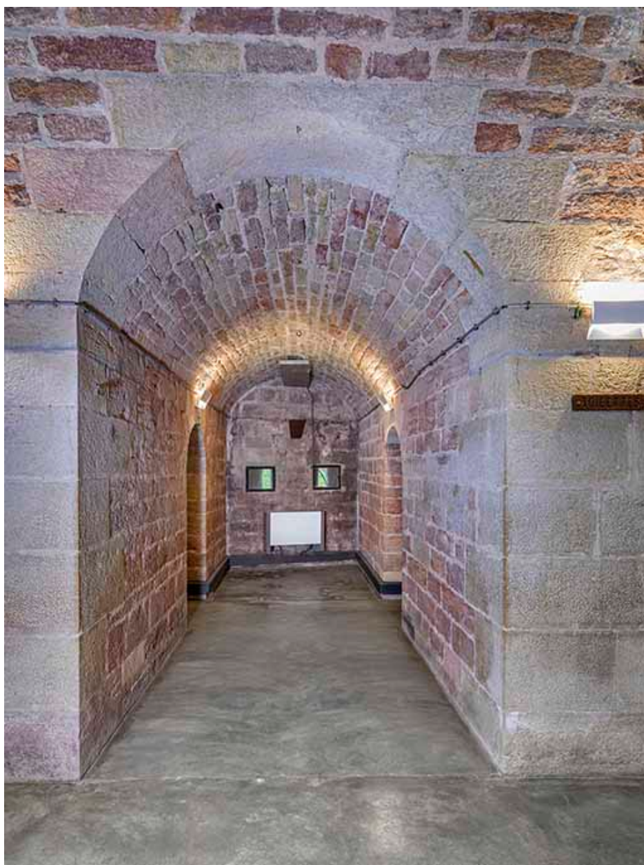
Tour Beauregard : galerie voûtée et embrasures, rez-de-chaussée.
