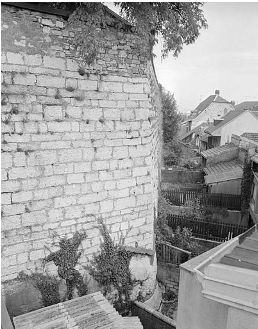
Enceinte. Partie sous le Vieux Château (i).
