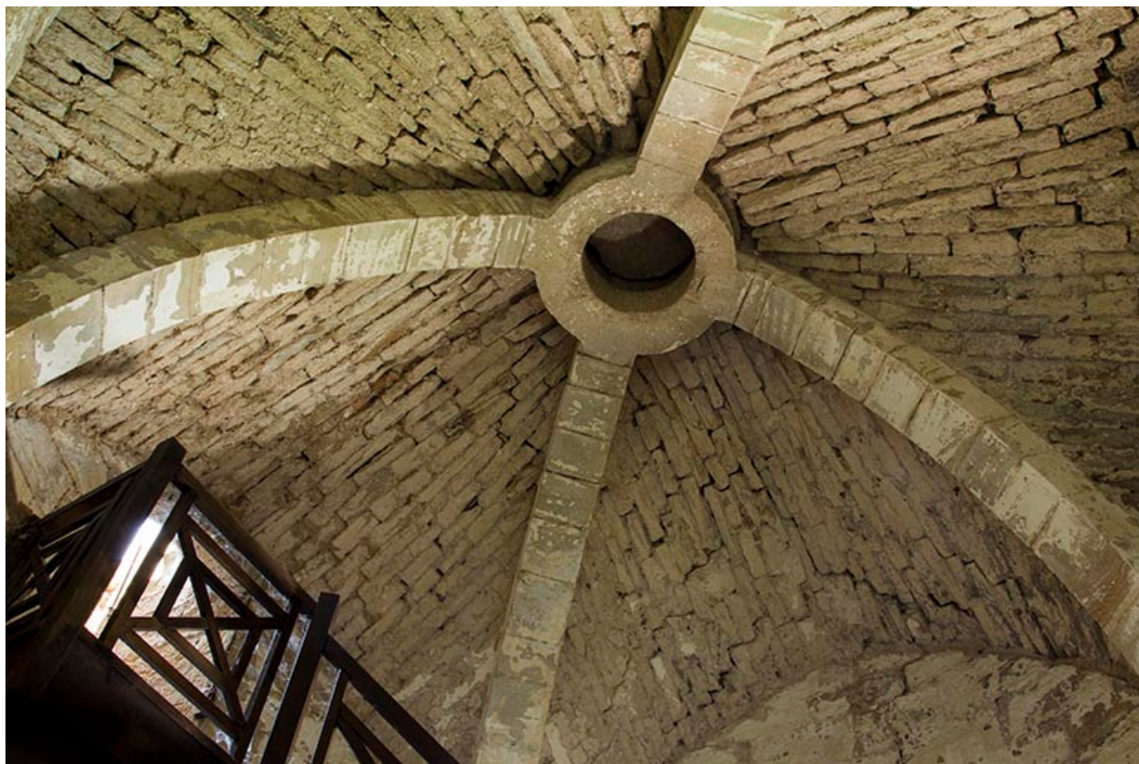
Le plafond voûté du rez-de-chaussée du donjon.
