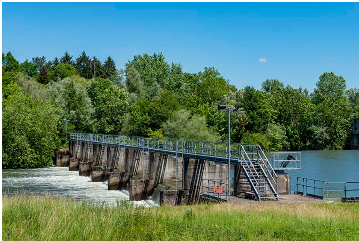
Le barrage mobile de Rigny.
