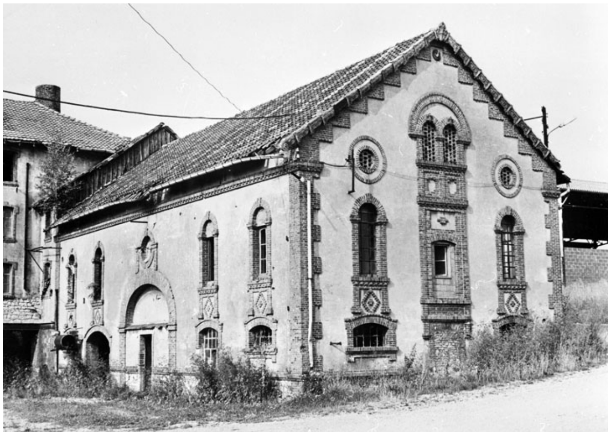
Briqueterie (?) vue de trois quarts vers 1980.
