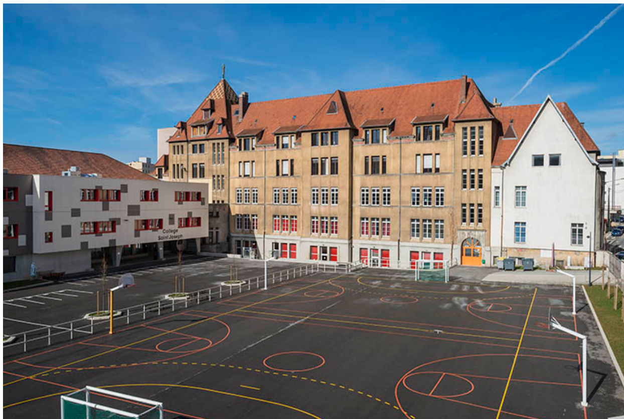
Façade postérieure du lycée.
