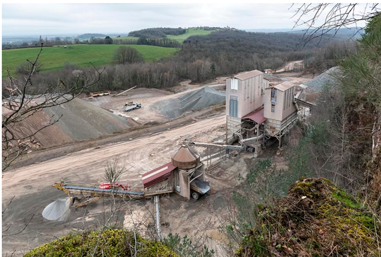
Carrière de Moisseuse : installations de concassage.
