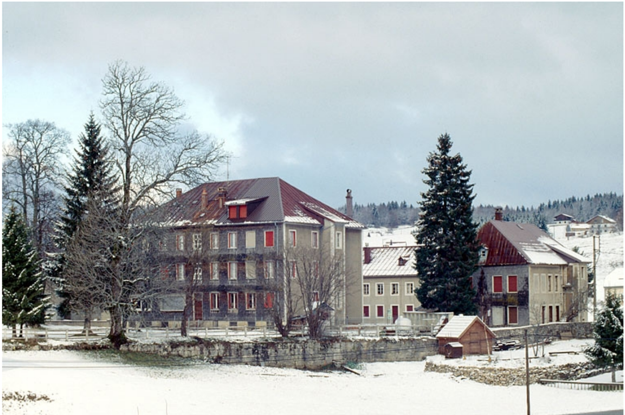
Vue d'ensemble depuis le sud-est, en hiver.
