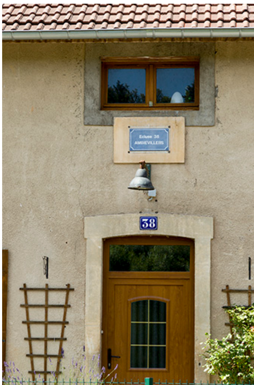
Plaque d'identification de l'écluse.
