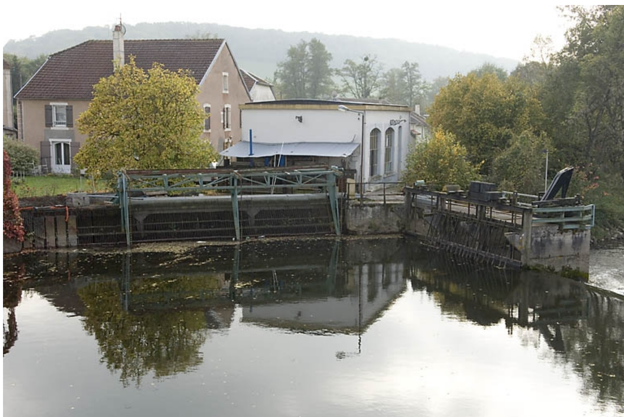
Vue d'ensemble depuis le pont.
