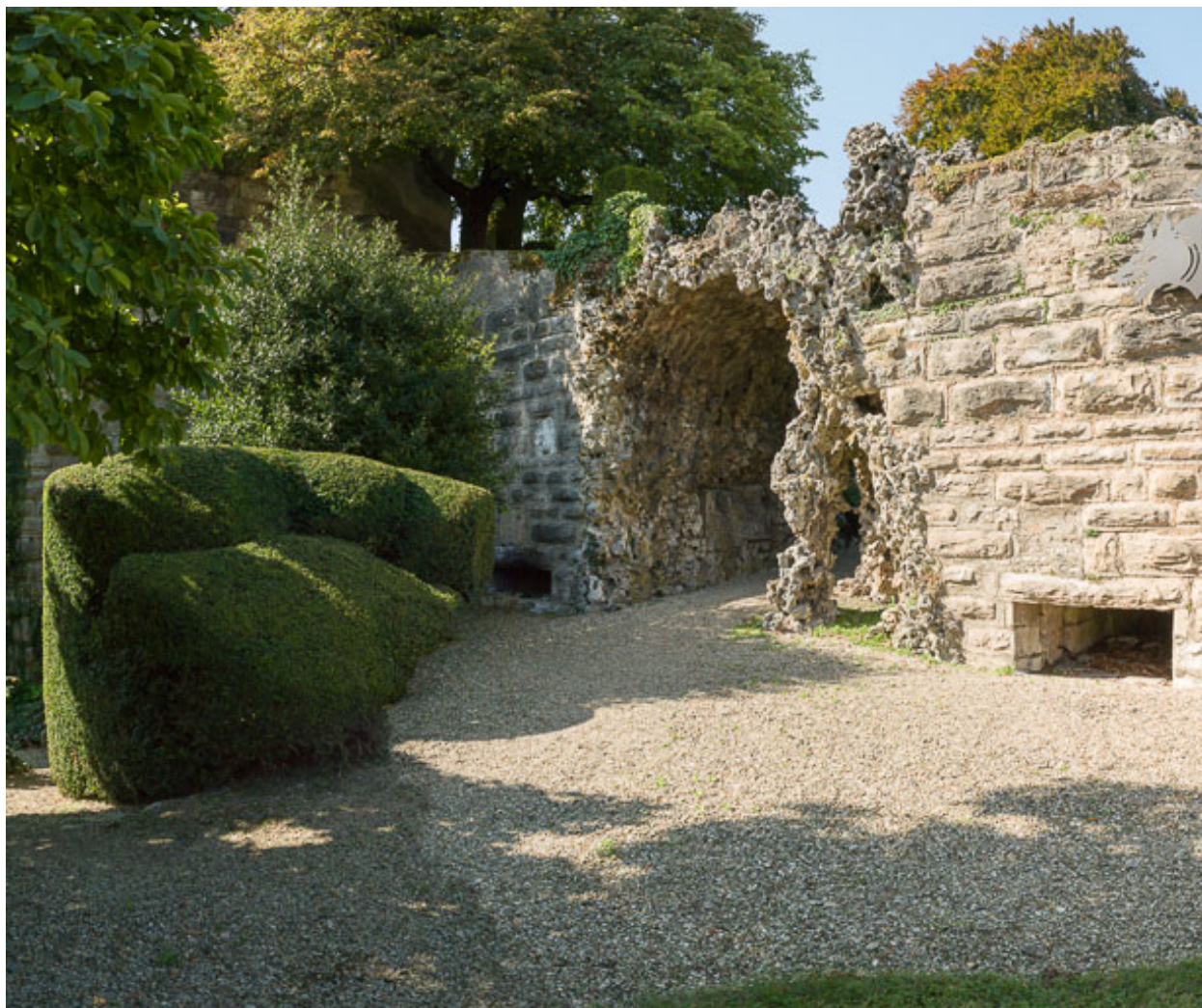
Passage aménagé dans l'ancienne courtine.
