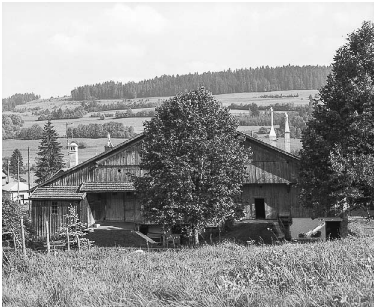
Façade postérieure en 1976.
