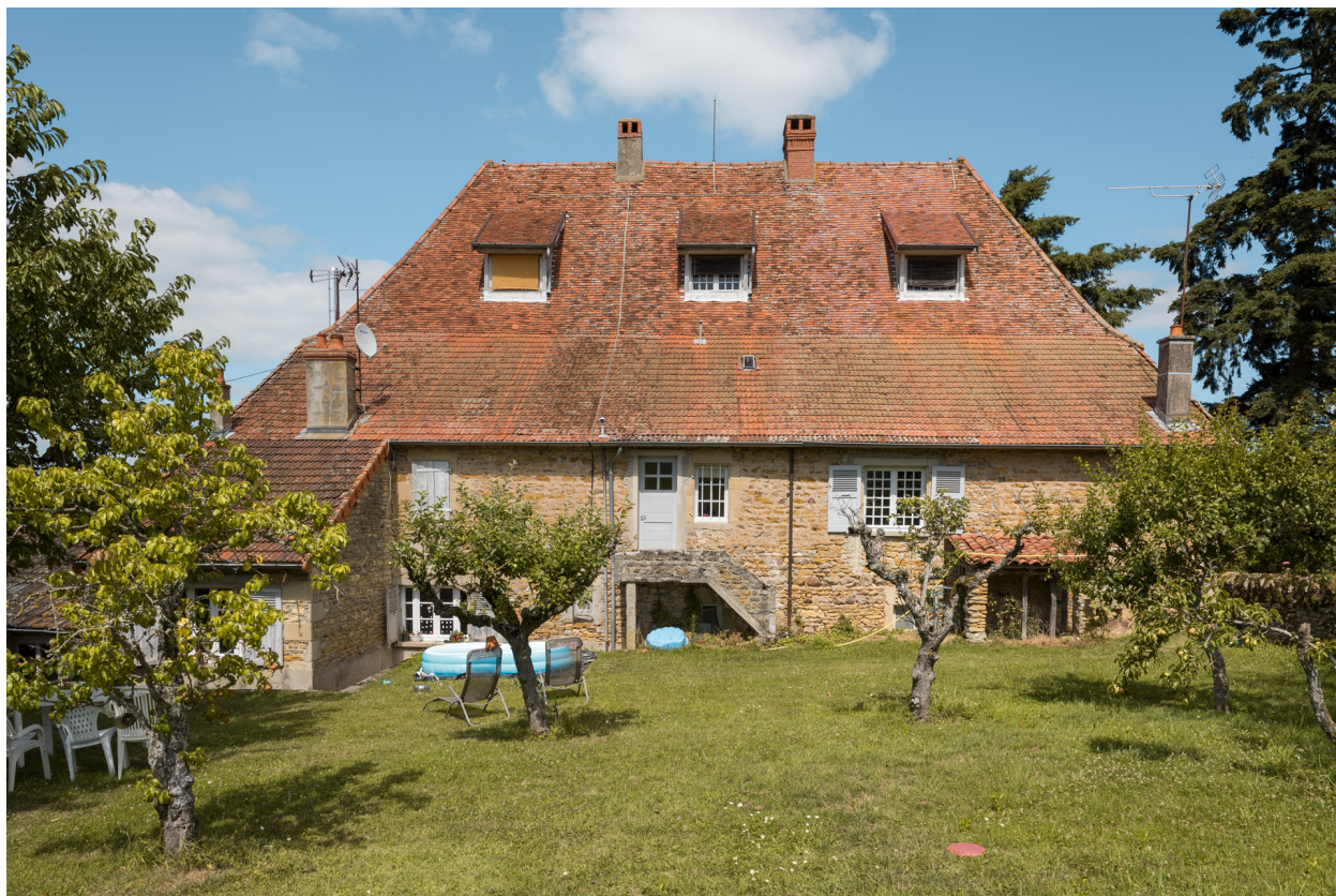
Façade postérieure du logement.
