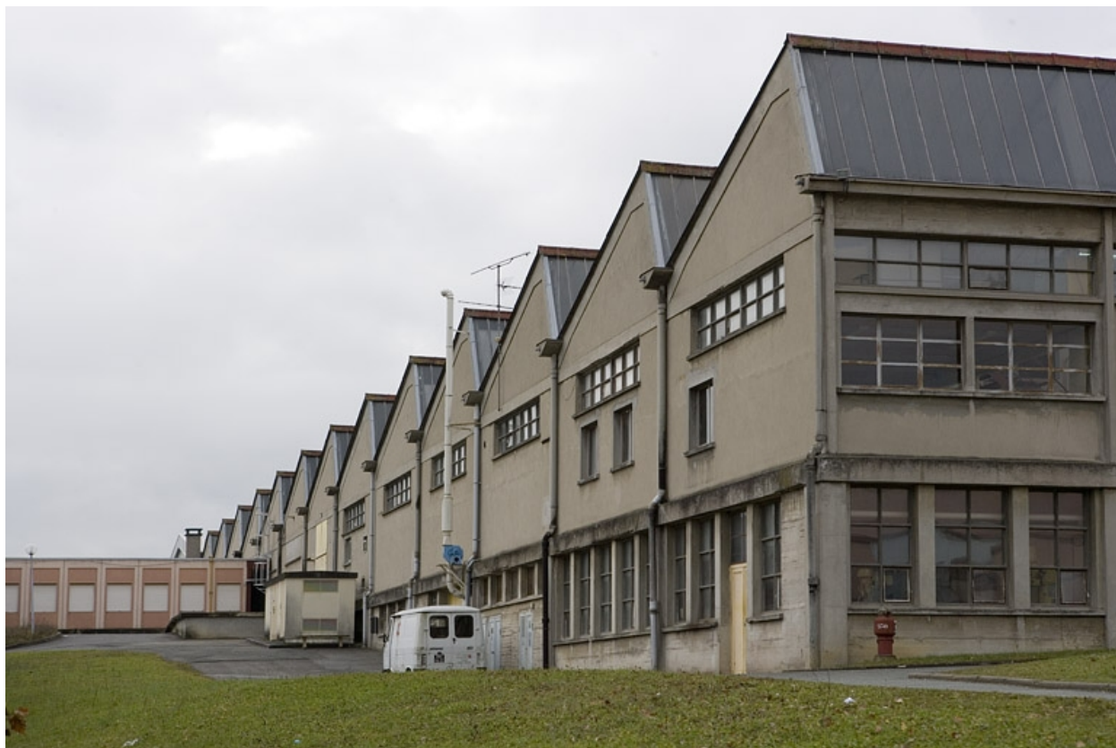
Vue de trois quarts droit bâtiment B.
