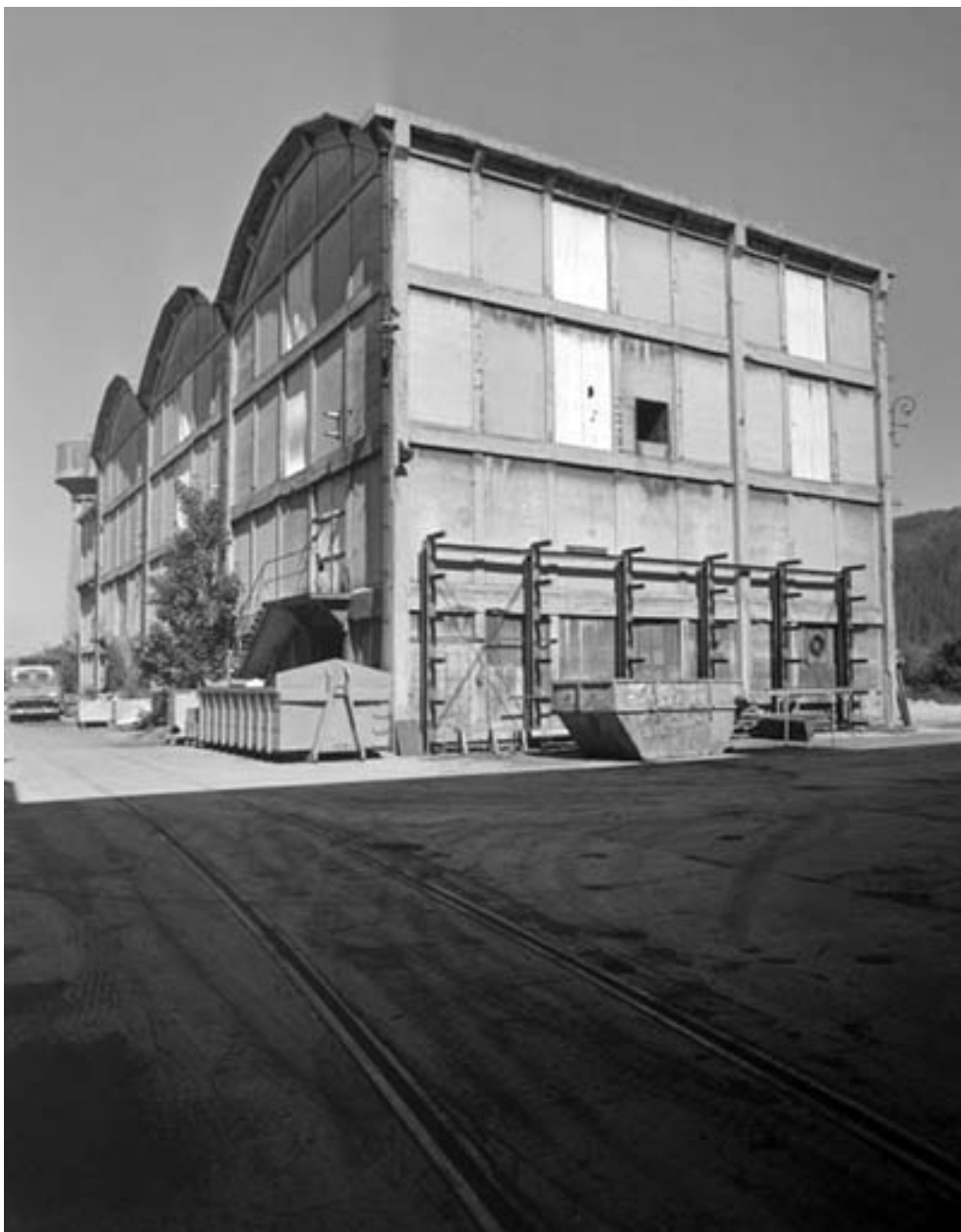
La centrale thermique vue de trois quarts.
