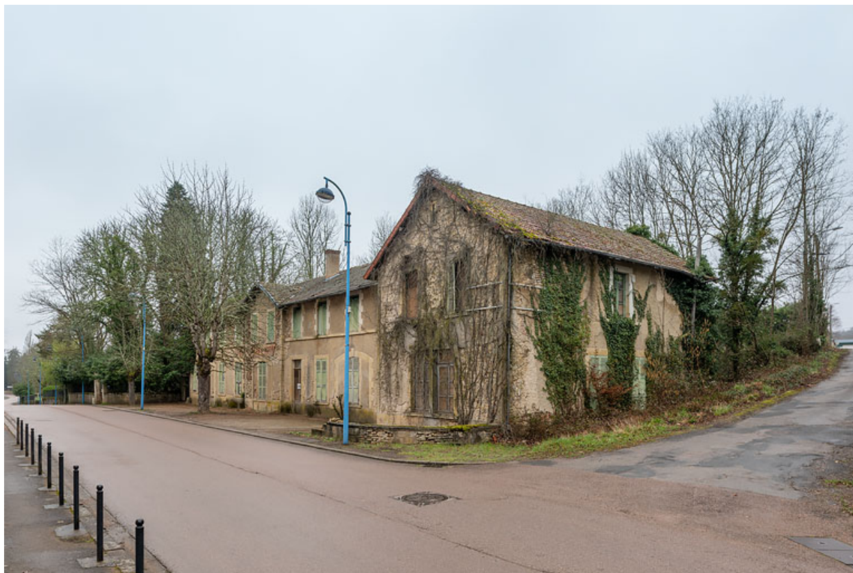
Façade principale, vue depuis le sud-est.
