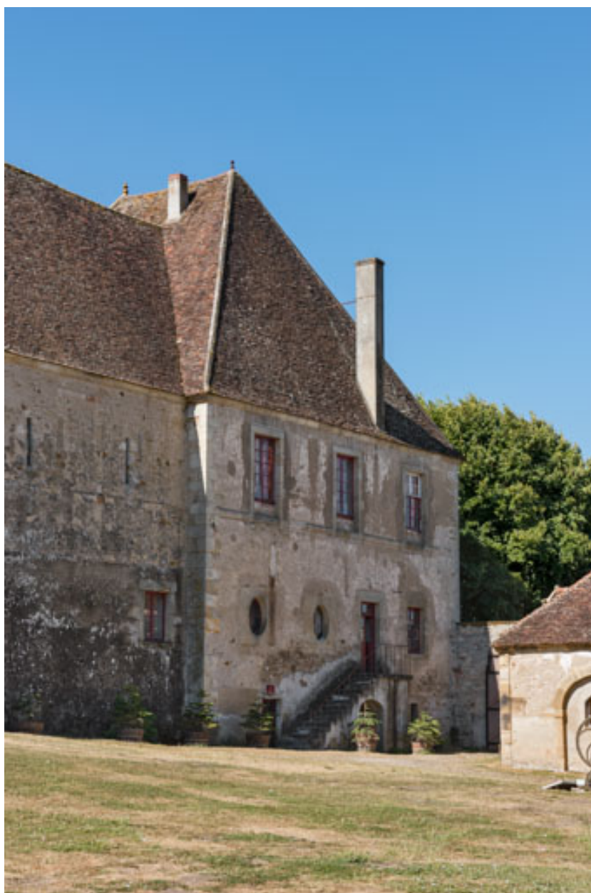
Façade postérieure : pavillon occidental.
