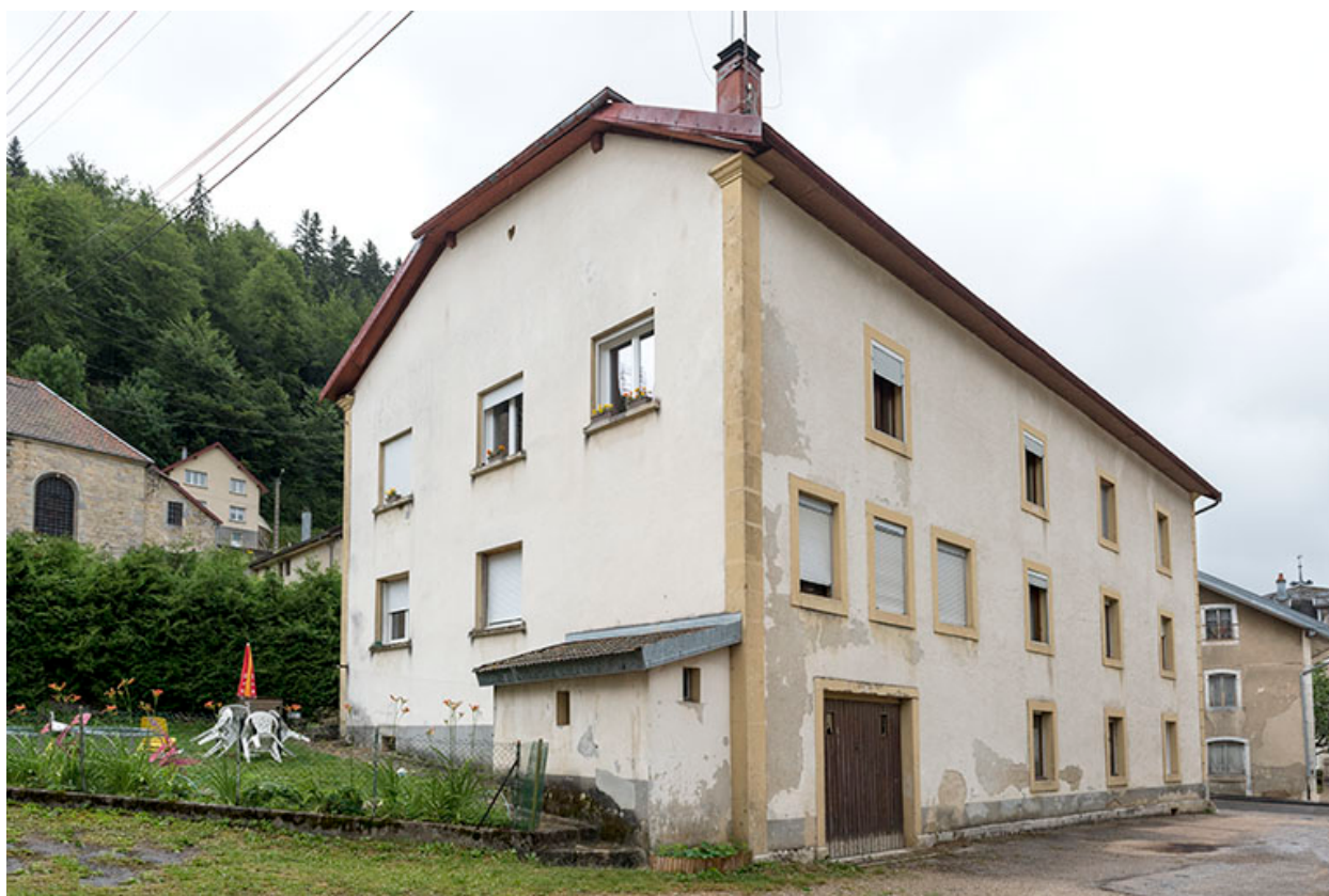
Façades postérieure et latérale gauche.
