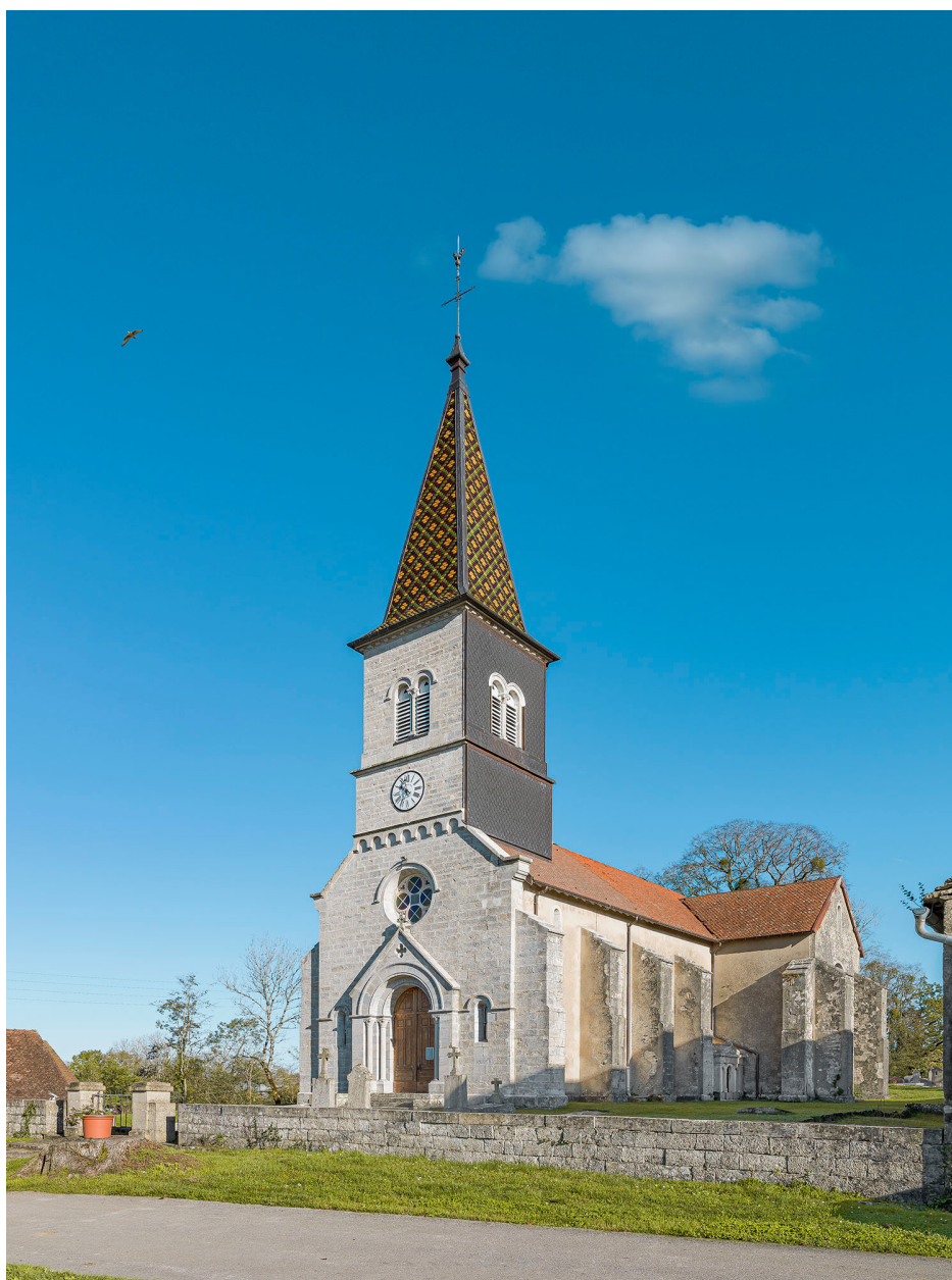
Façade principale et élévation sud.
