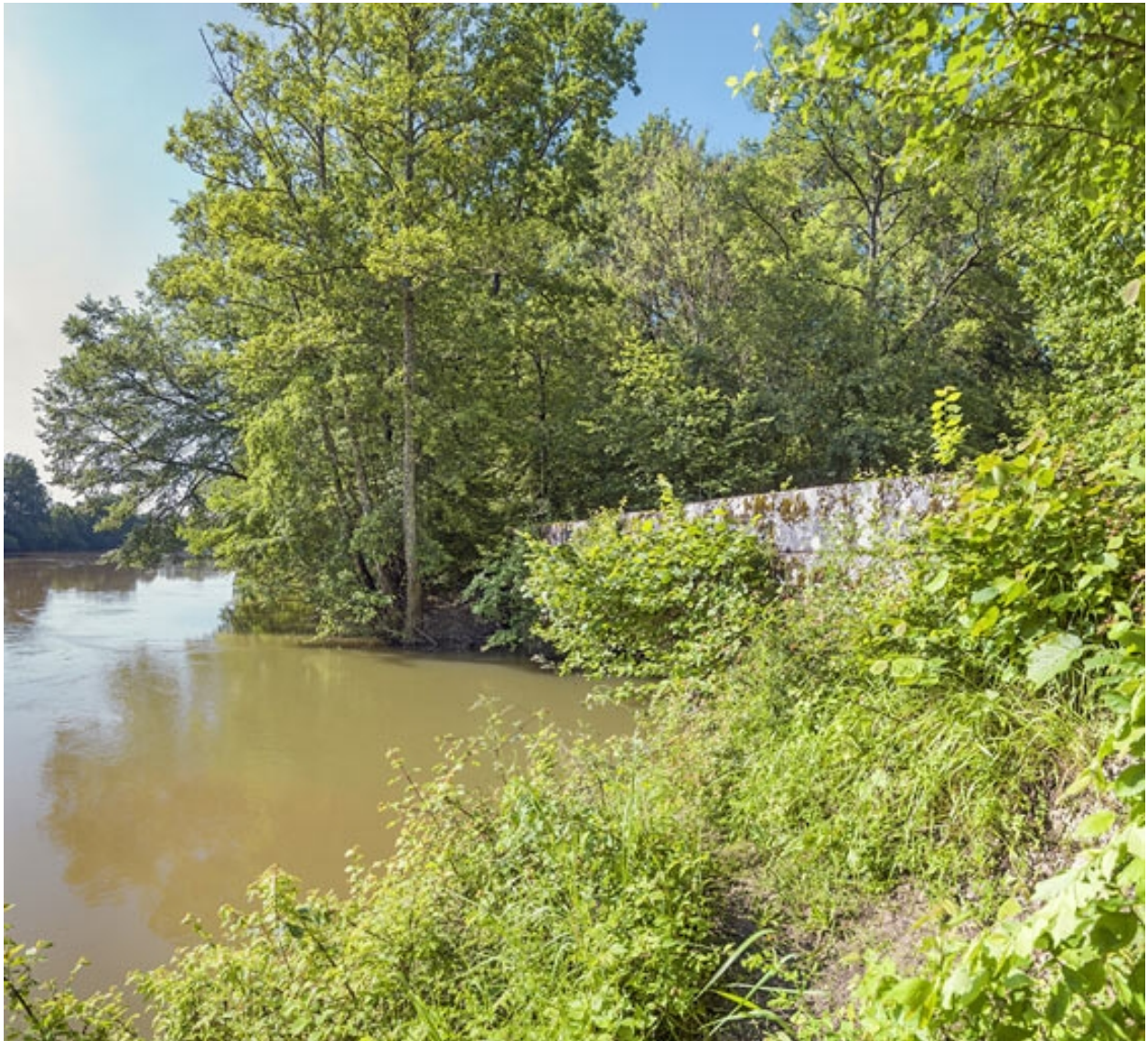
Le pont, vu depuis la Saône.
