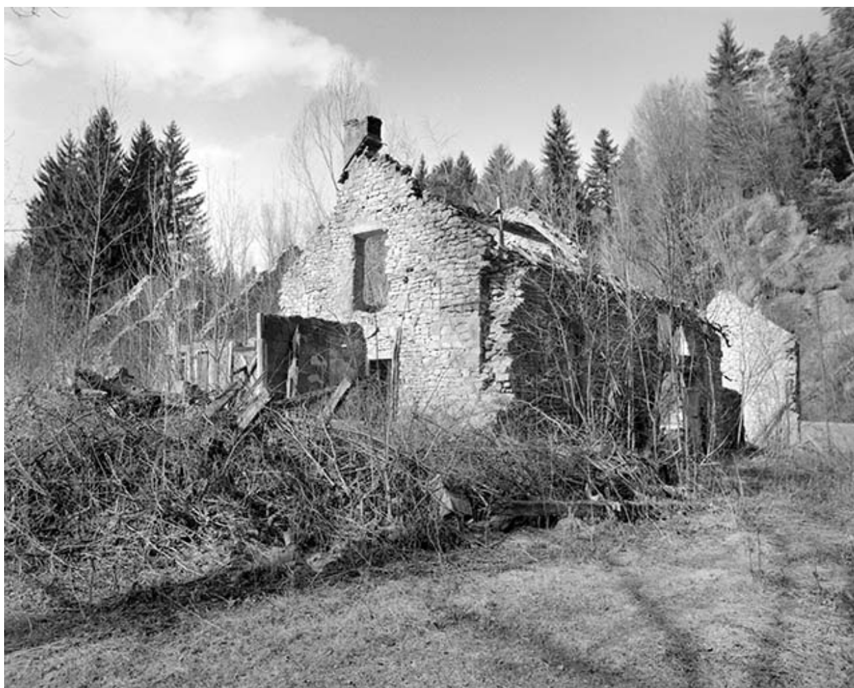
Aile sud du logement patronal.
