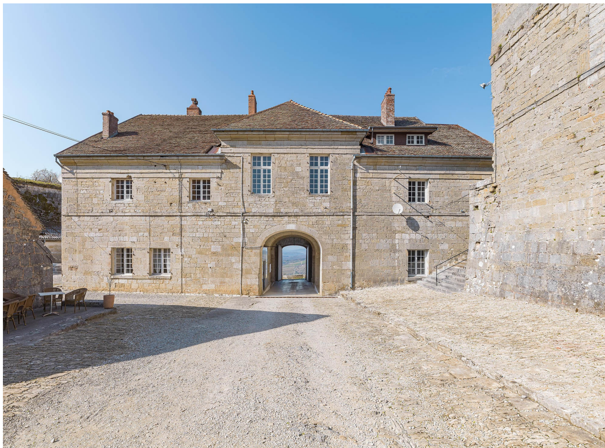
Façade postérieure du bâtiment.
