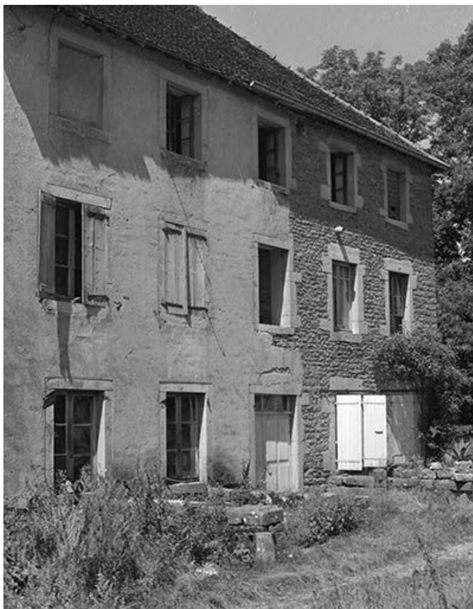
L'habitation : façade sur cour, détail.
