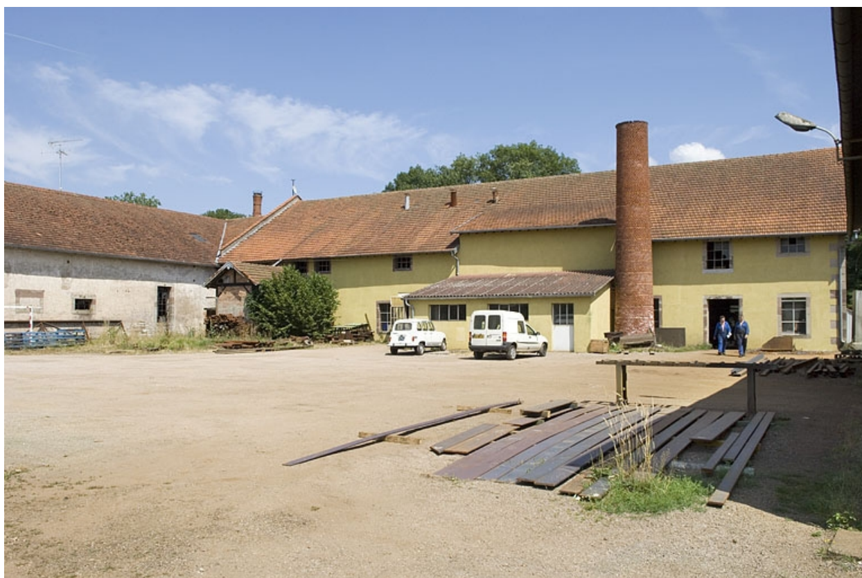
Bâtiments industriels depuis la cour.
