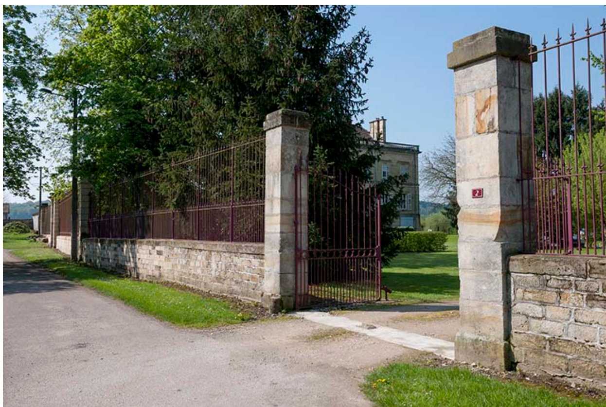
Portail d'accès aux parties agricoles.
