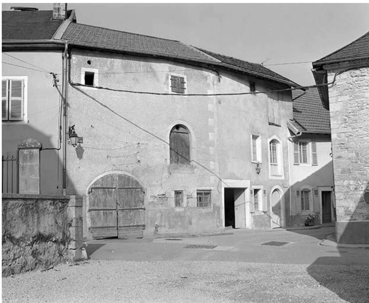
Maison située 2 rue Pavée.
